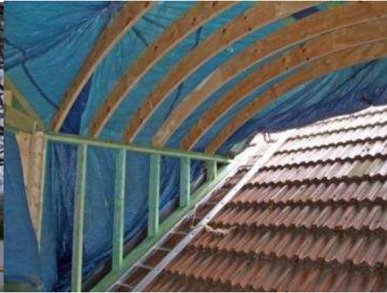
Extension à Marcinelle. Bardage en cèdre. Isolation ouate de cellulose
