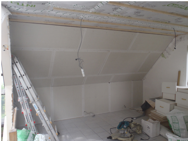
Pose des plaques de finition
