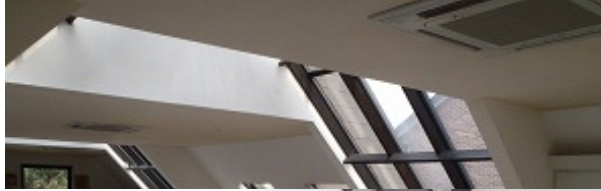
Démontage de l'existant
