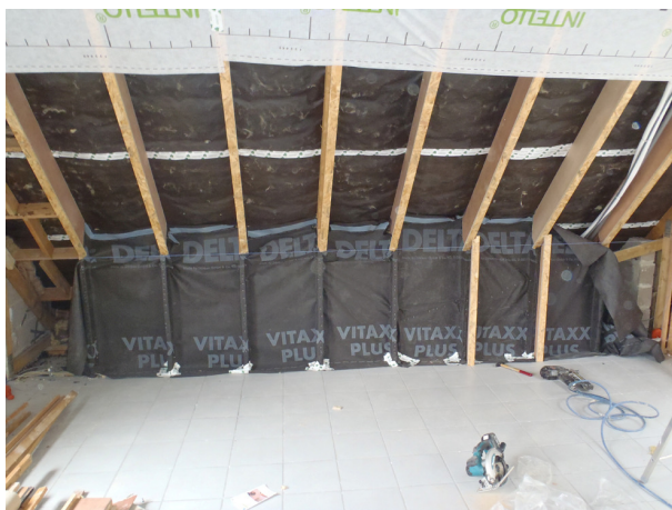
Augmentation de l'épaisseur d'isolation et mise en place d'une sous-toiture aux endroits où il n'y en a pas.
