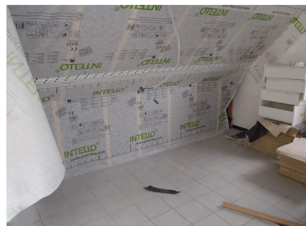
Étanchéité à l'air
